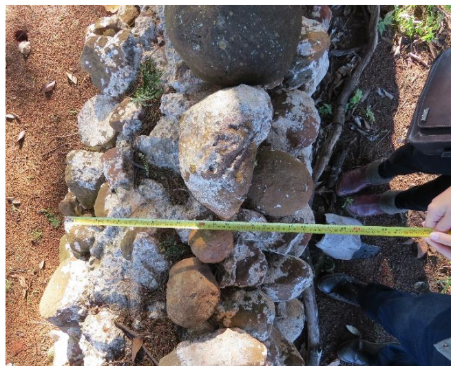
Figura 23: Medição da espessura dos muros da construção.
