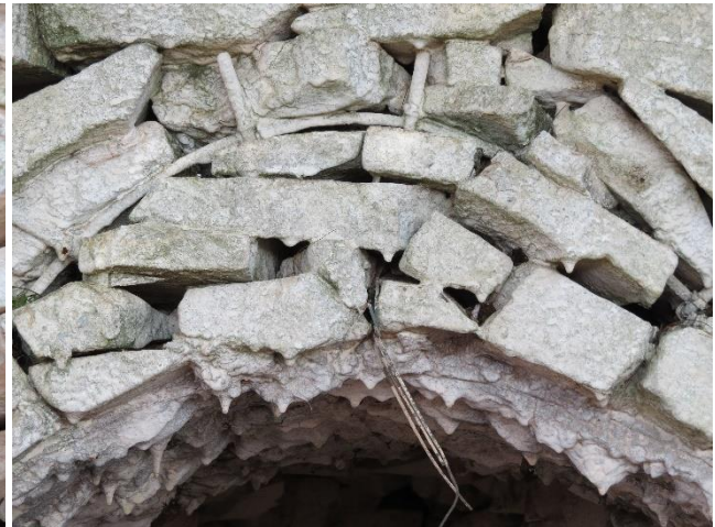
Figura 26: Vergalhões metálicos reforçando o vão do arco de abertura
