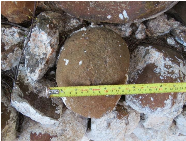
Figura 20: Exemplo de bloco de rocha utilizado na estrutura.
