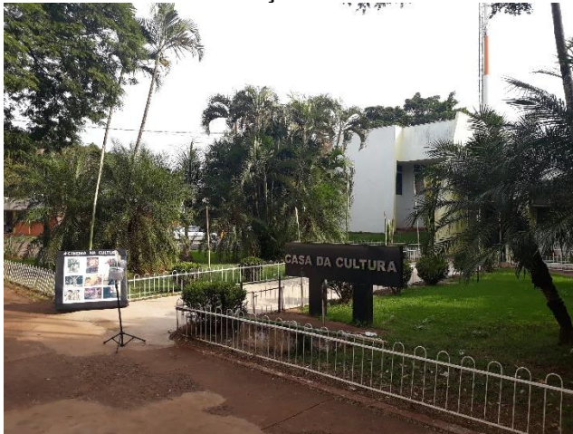
Figura 11: Fachada da Casa de Cultura de Paiçandu
