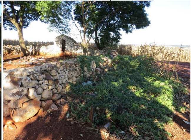
Figura 36: Fachada lateral da edificação (face sudoeste)
