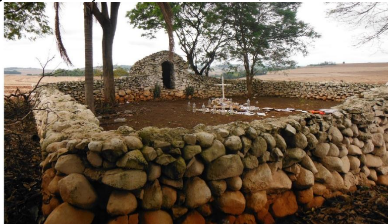
Figura 44: Situação da estrutura em 2014, sem danos nos muros.
