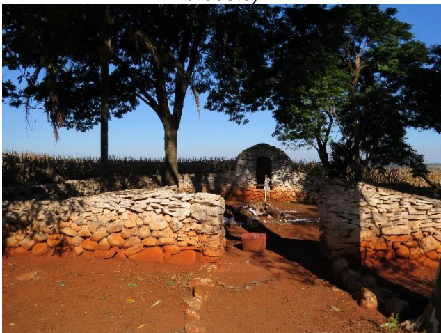
Figura 32: Fachada frontal da edificação (face noroeste)
