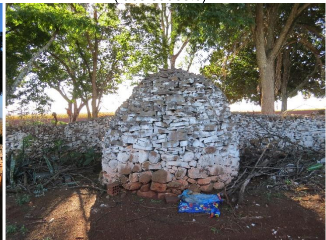
Figura 33: Fachada posterior da edificação (face sudeste)
