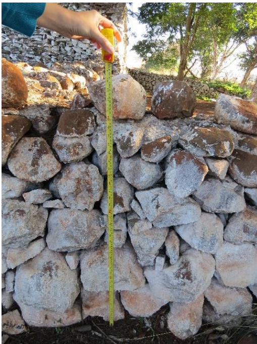
Figura 22: Medição da altura dos muros da construção de blocos empilhados.
